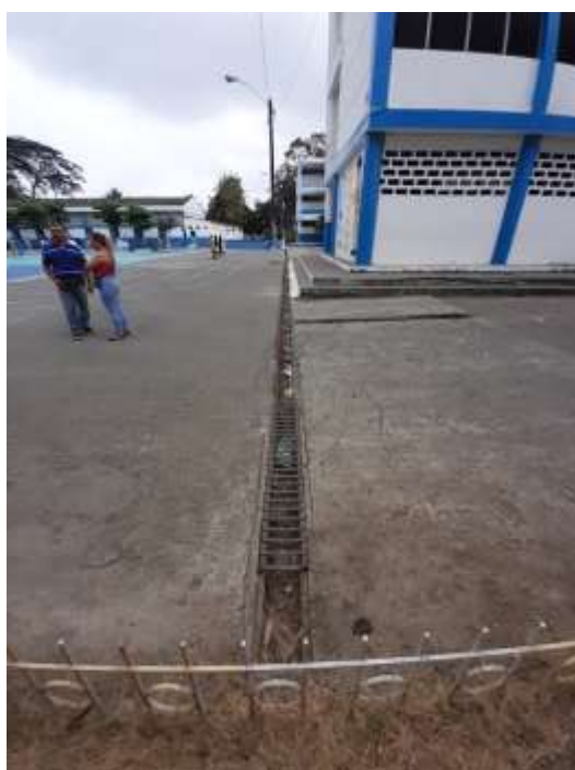
Canal de Hormigón Simple con rejillas metálica.
