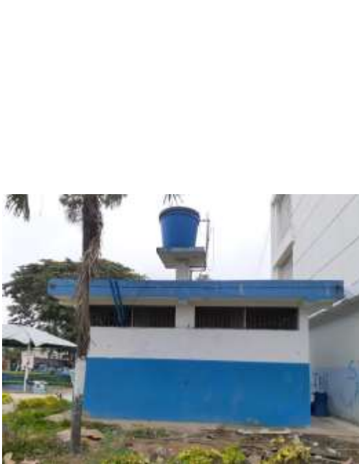
Tanque de PVC de 500 Lt. que abastece de agua al baño de los docentes.
