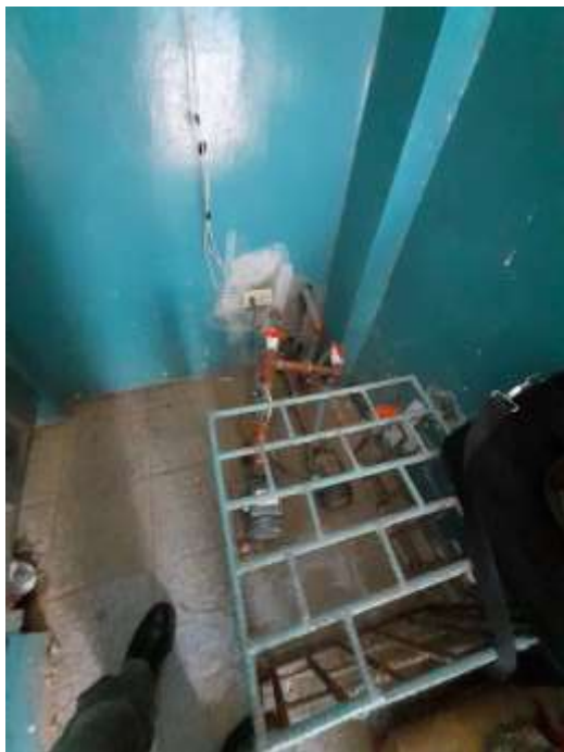
Bombas usadas para sacar el agua de pozo ubicada en el baño de los docentes y estas a su vez la envían a la cisterna de Hormigón Armado del bloque 1 y al tanque elevado de PVC. Del baño de los docentes.
