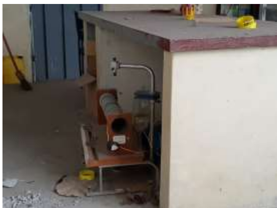
Bomba marca Pedrollo de HP de 1", ubicada en la planta baja del Bloque Internacional, la misma que envía el agua desde la cisterna hasta el Tanque elevado de PVC .
