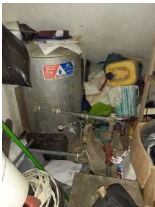
Tanque Hidroneumático marca Almetal, presión 100 psi, ubicada en la planta baja del bloque de Administración
