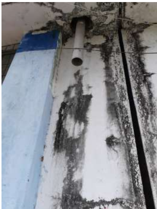
Bajantes existentes con Tubería PVC de 4".
