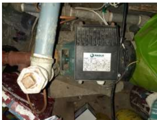
Bomba marca Paolo, HP 1", ubicada en la planta baja del bloque de Administración
