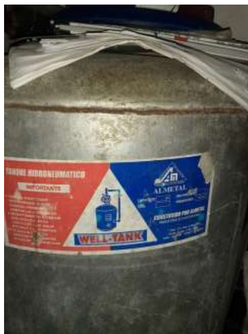
Tanque Hidroneumático marca Almetal, presión 100 psi, ubicada en la planta baja del bloque de Administración
