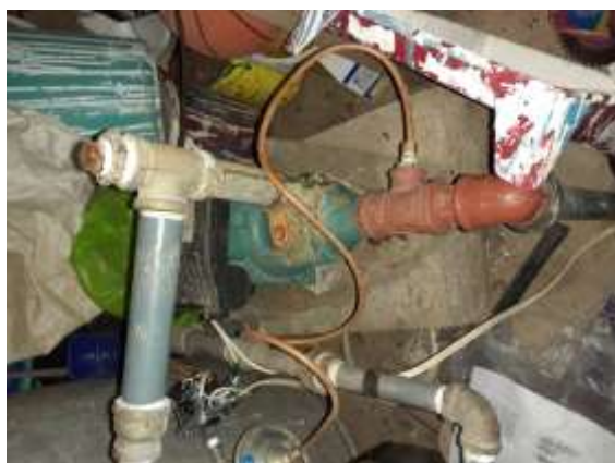
Bomba marca Paolo, HP 1", ubicada en la planta baja del bloque de Administración
