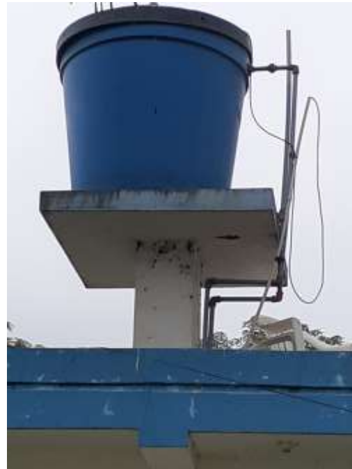
Tanque de PVC de 500 Lt. que abastece de agua al baño de los docentes.
